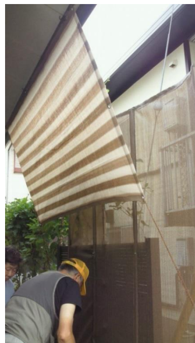
簾の取り付け作業
